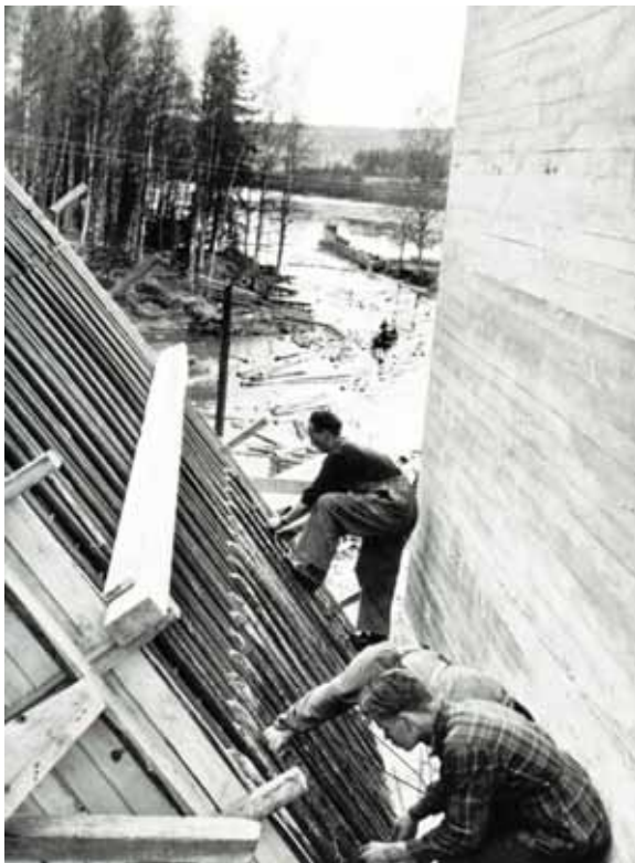
Siltaa raudoitetaan Äänekosken ja Saarijärven välillä toukokuussa 1954. Kuva: Kauko Kippo, Keski-Suomen museon kuva-arkisto.
